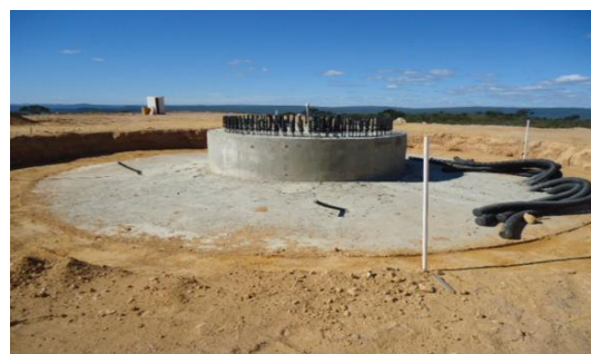
Fundação sendo preparada para a montagem da turbina
