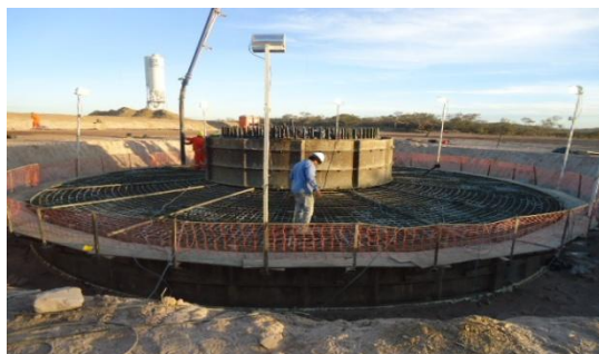
Concretagem de fundações
